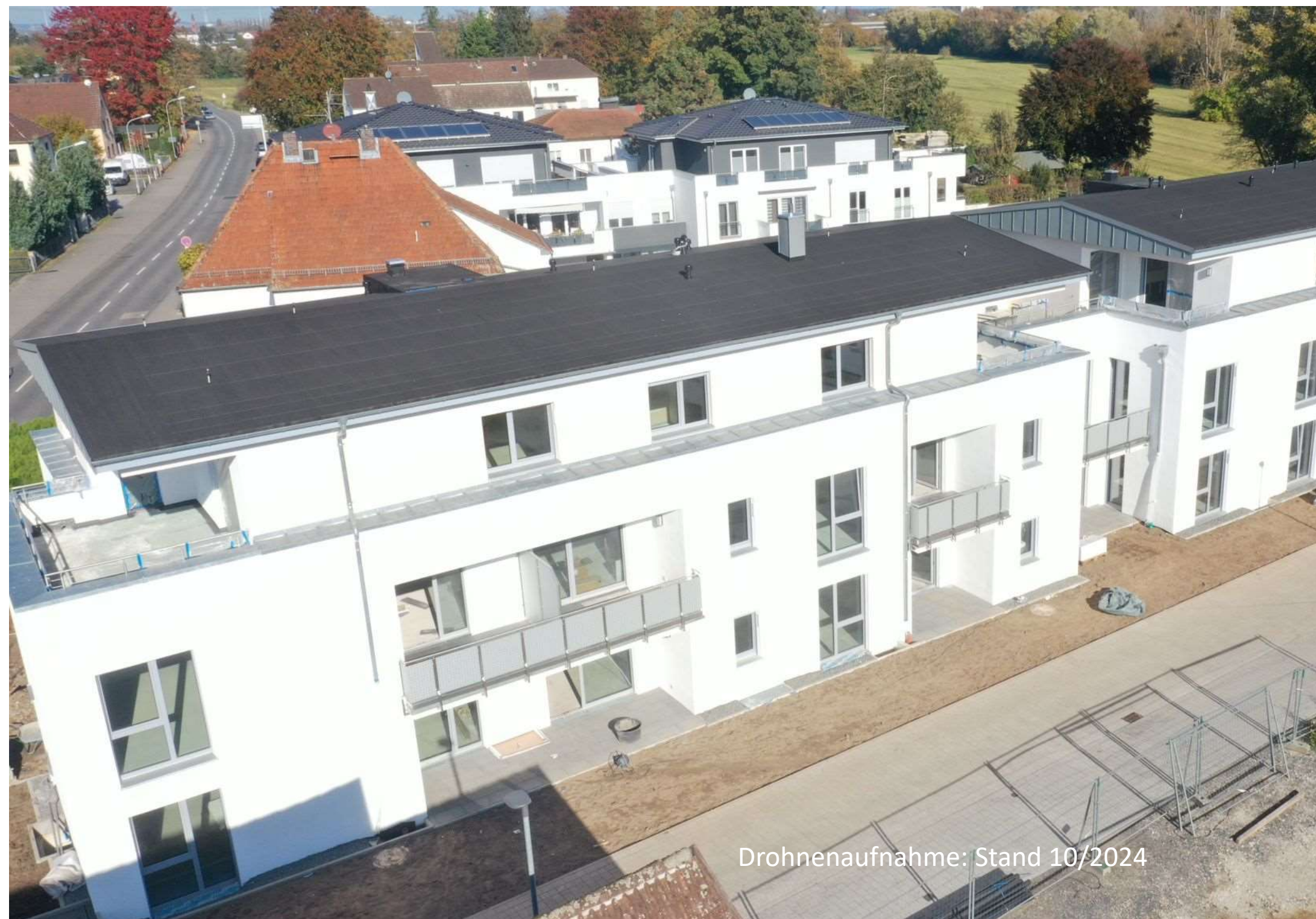
Gartenansichten Haus 1A und 1B (von links nach rechts)
